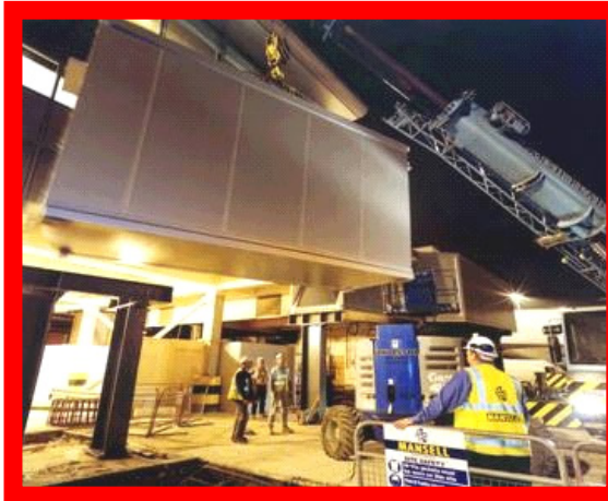
Link Bridges T1 LHR
